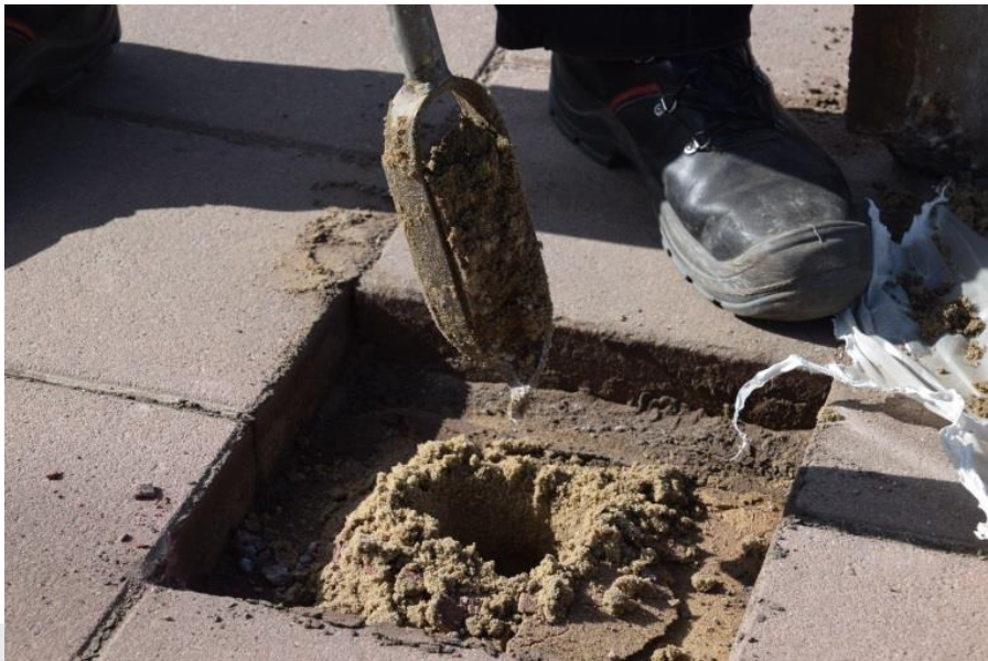
Uitvoering handboring onder verharding.
